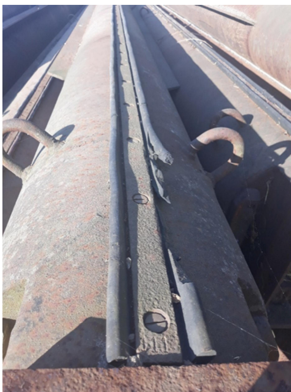
Foto č.2 – těsnící profil a přitlačná lišta
